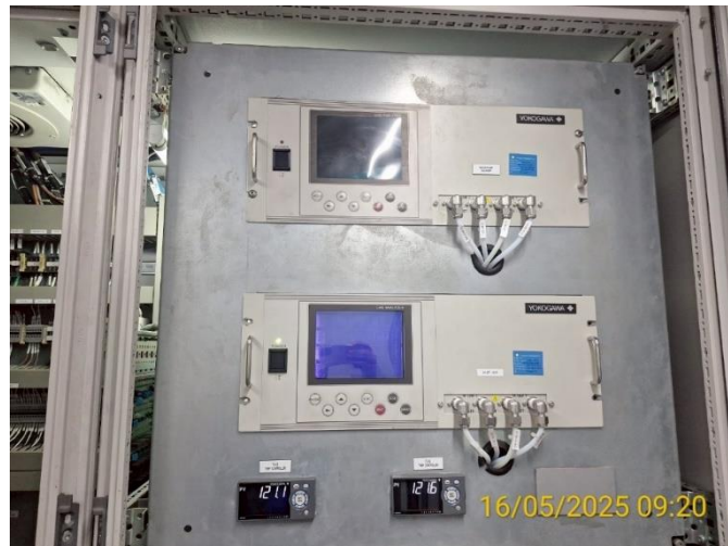
ภาพที่ 3.3-1 การตรวจวัดคุณภาพอากาศจากแหล่งกำเนิด – ด้วยระบบ ติดตามตรวจวัดมลพิษทางอากาศแบบอัตโนมัติ (CEMs)
